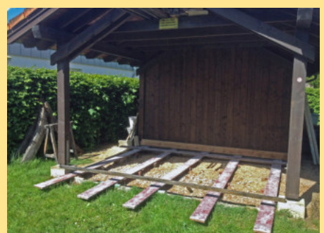
Der neue Boden wird ausgerichtet und angeschraubt.
