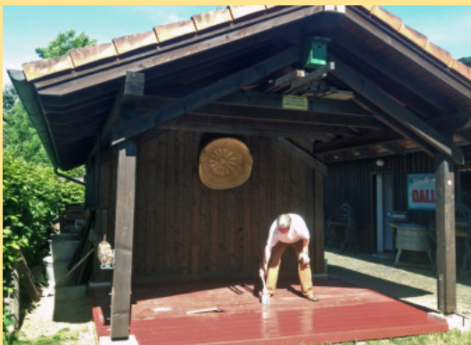
Der Boden erhält hier mit neuer Farbe den letzten Schliff!
