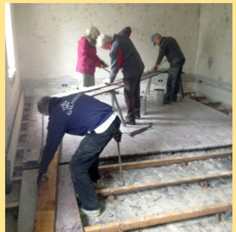
Staubige und schweißtreibende Angelegenheit: Viele Nägel wollen gezogen werden!
